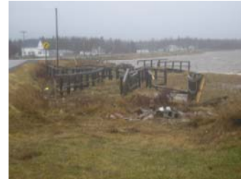
Les passerelles de la Dune de Bouctouche, 2010
